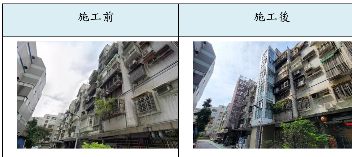
圖 21 信義富台社區增設電梯施工
